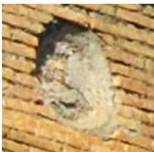
n.2: L'alloggiamento è stato realizzato risparmiando più filari di mattoni, creando una cavità a misura per il manufatto che, successivamente è stata rivestita da uno strato di malta per ancorare il bacino.
