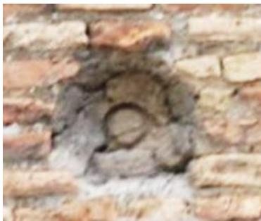
n.10: Il bacino venne inserito rompendo più filari di laterizi. La cavità conserva ancora lo strato di malta con la traccia del piede ad anello.
