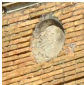
n.8: Alloggiamento come il n.2, ma la cavità è stata rivestita da uno strato di malta levigata, soluzione molto simile all'Abbazia delle Tre Fontane. È, quindi, probabile che l'alloggiamento sia stato rivestito durante un intervento di restauro, per mascherare la mancanza del bacino.
