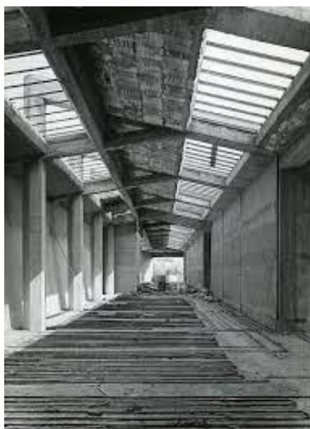
Figura 8: La nuova sede in costruzione, da GAM "Storia di un edificio", presso artsandculture.google.com
