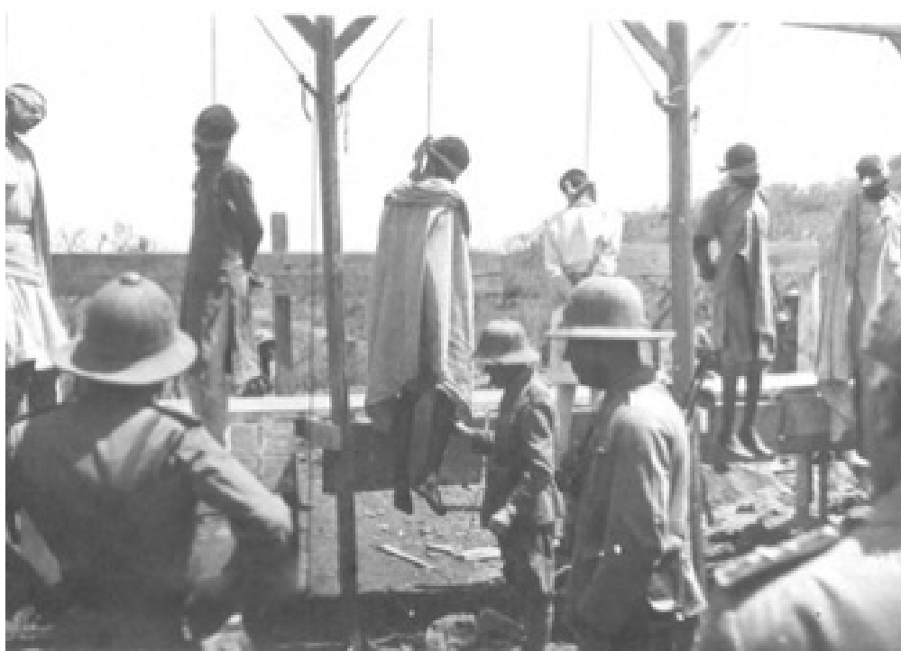
Esecuzione sommaria ad Addis Abeba
