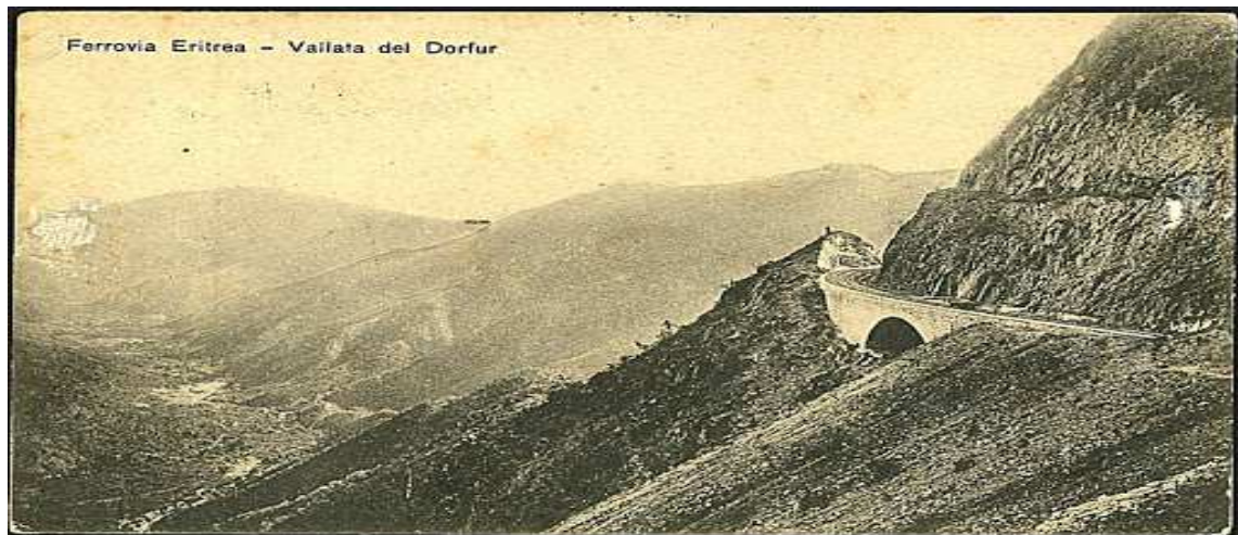
Ponte ferroviario in Eritrea
