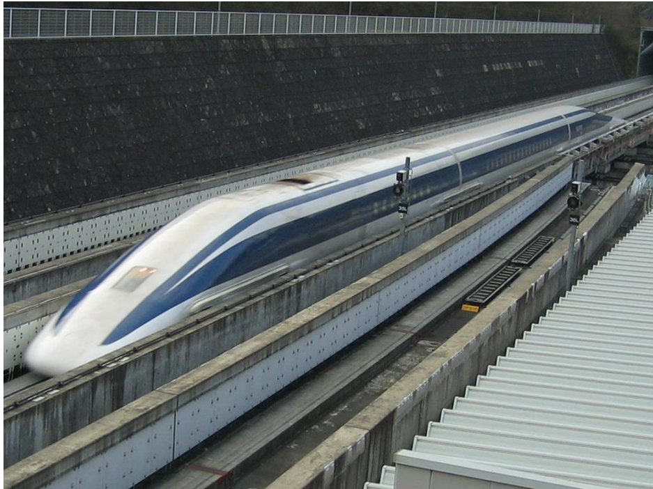
Figura 1: Foto del treno Maglev MLX-01 durante uno dei test condotti dalla JR su un tratto di linea sperimentale. La linea a levitazione magnetica collegherà Tōkyō a Nagoya e la sua inaugurazione è prevista per il 2027. FONTE: Wikimedia Commons
