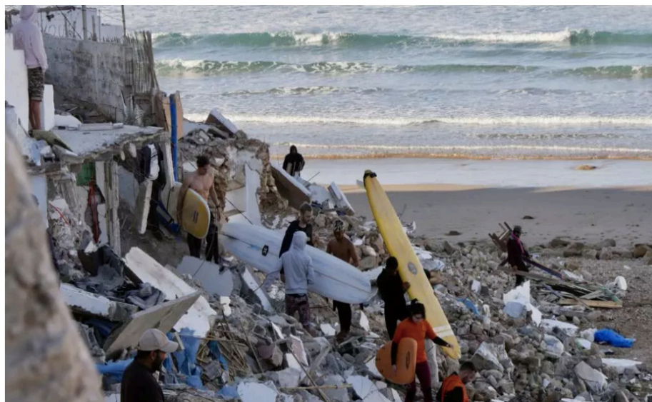
Figura 3.5.: Il quartiere la Cathédrale a Imsouane dopo le demolizioni.
