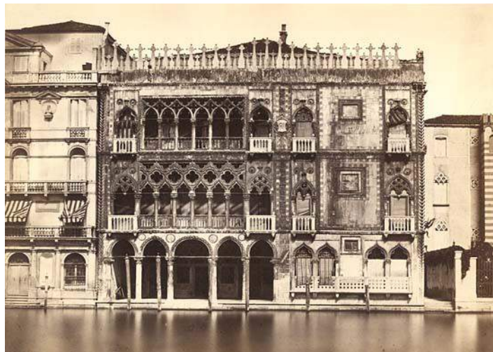
Illustrazione 1.9. Facciata del Palazzo Franchetti (Ca' d'Oro) dopo i lavori di restauro di Giovan Battista Meduna di metà Ottocento. (Fonte: wikipedia.it).
