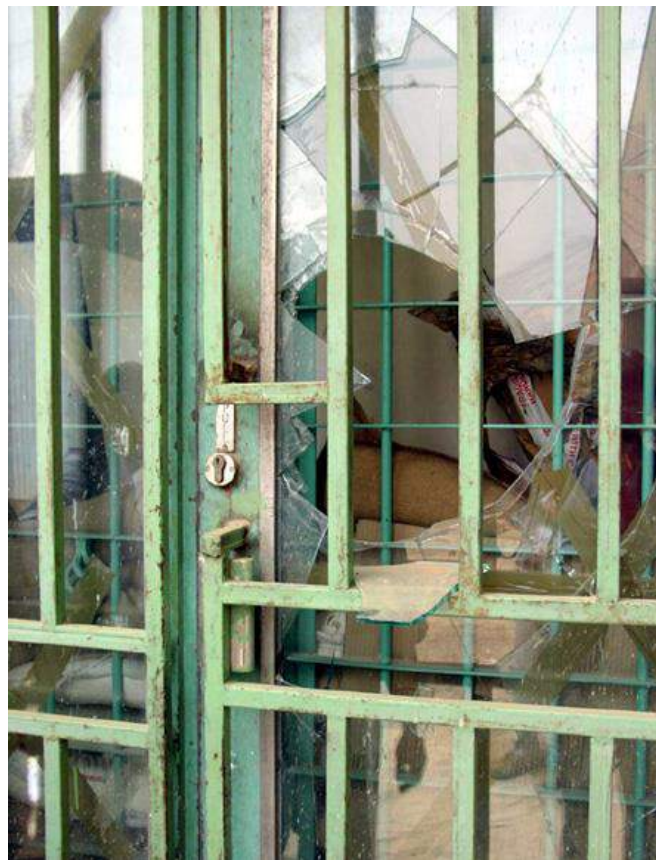
Figura 3. La porta di servizio utilizzata per evacuare l'edificio e poi distrutta dai saccheggiatori per accedere al museo. Foto di Joanne Farchakh-Bajjalay.
