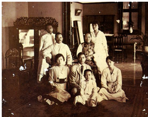
fig.1 Ritratto della famiglia Song, autunno 1917 circa. Meiling è in piedi alle spalle della madre, T.L. alle spalle del padre. Per terra, da sinistra a destra, sono seduti Qingling, T.V., Ailing e in primo piano T.A.
