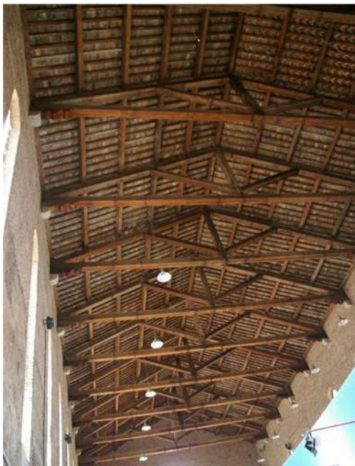
Fig. II.14: la copertura della Chiesa prima dei lavori di restauro dell'edificio del 2014.
