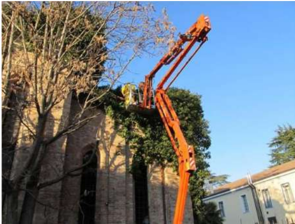
Fig. II.16: una delle operazioni per la rimozione della vegetazione rampicante.
