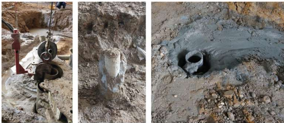
Fig. II.30: alcune fasi della posa dei micropali di fondazione.
