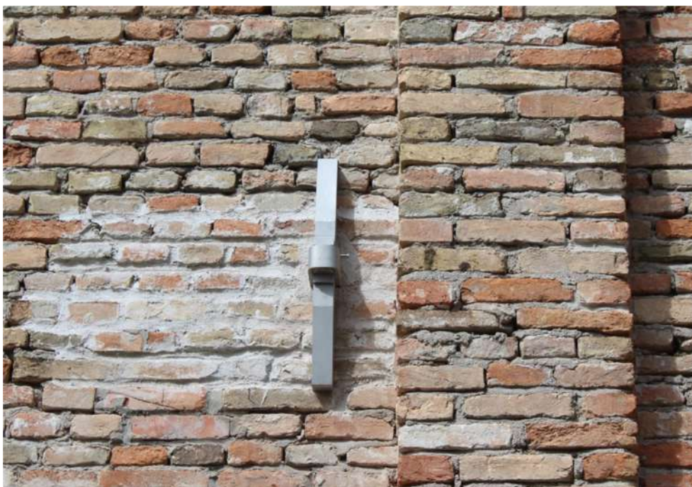
Fig. II.20: l'aggancio con capochiave a paletto dei tiranti interni alla struttura.
