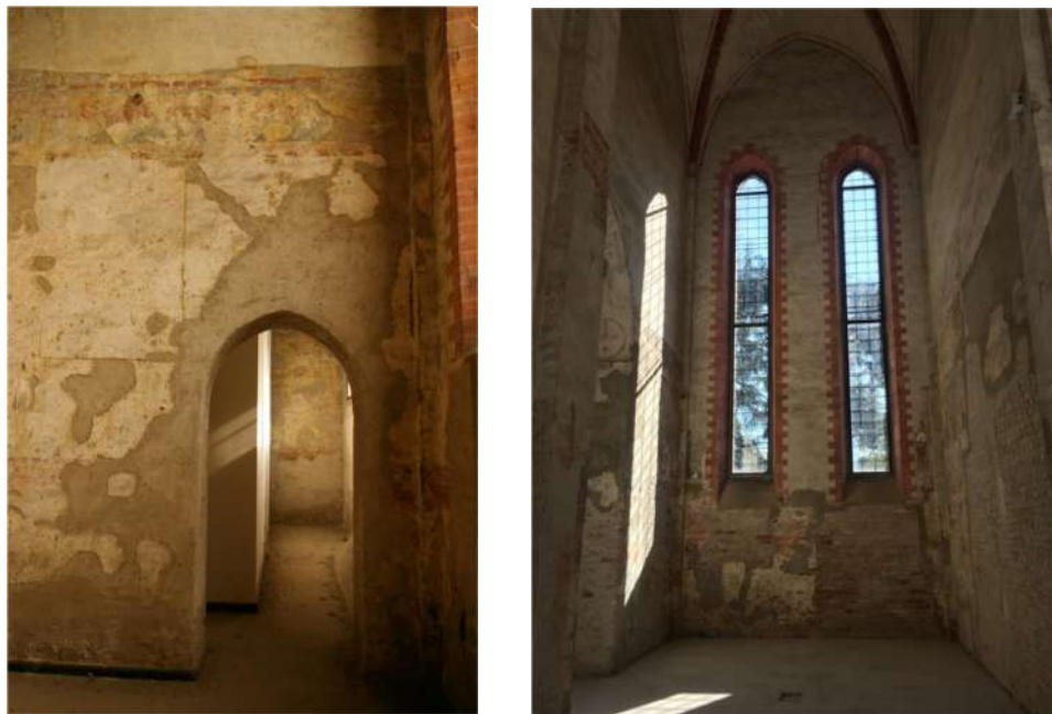
Fig. I.8-9: (a sinistra) la piccola apertura che collega la cappella absidale centrale con la cappella di Sant’Orsola; (a destra) le finestre presenti in entrambe le cappelle absidali laterali.
