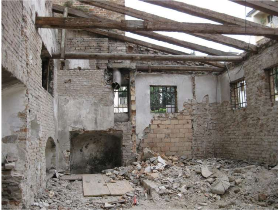
Fig. II.17: fase di smantellamento del corpo degli ex spogliatoi.
