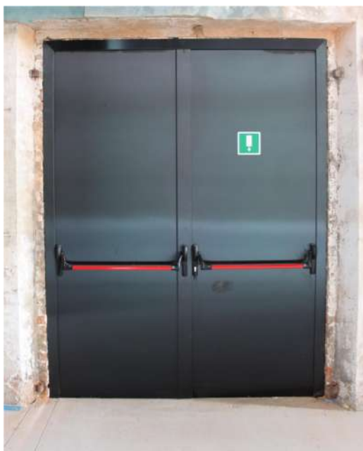
Fig. II.31: la nuova apertura presente sul lato est.
