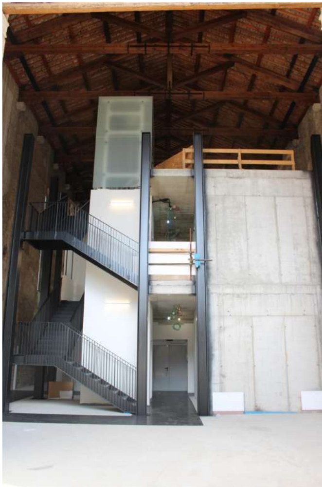
Fig. II.25: il lato sud della nuova struttura interna.
