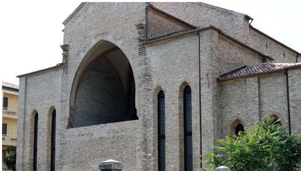
Fig. II.21: la zona absidale e la nuova apertura ad arco.
