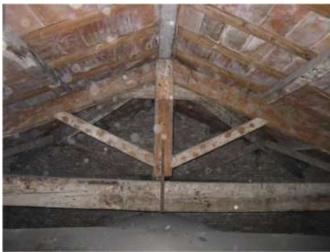
Fig. II.3-4: (a sinistra) una capriata della zona absidale con i riconoscibili tavelloni forati; (a destra) l'esecuzione di una prova per la verifica dello stato di conservazione della testa di uno dei barbacani.
