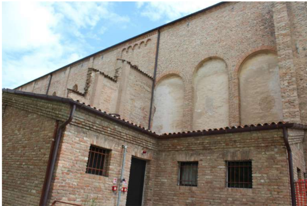
Fig. I.19: i corpi adiacenti alla parete ovest, che ospitavano gli ex spogliatoi sovrastati dagli archi a sesto acuto.
