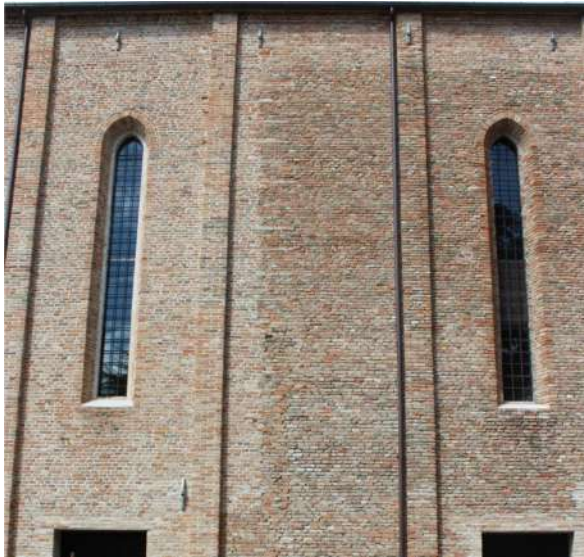
Fig. II.2: la discontinuità verticale visibile lungo la parete est.
