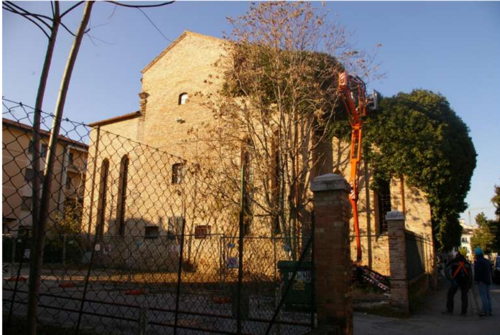
Fig. I.18: la parete sud come si presentava prima dei lavori del 2014 quando è stata rimossa la vegetazione rampicante che copriva buona parte della cappella di Sant'Omobono sulla destra.
