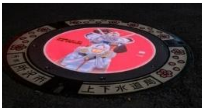
19. Esempio di chiusino a LED illuminato a Tokorozawa
