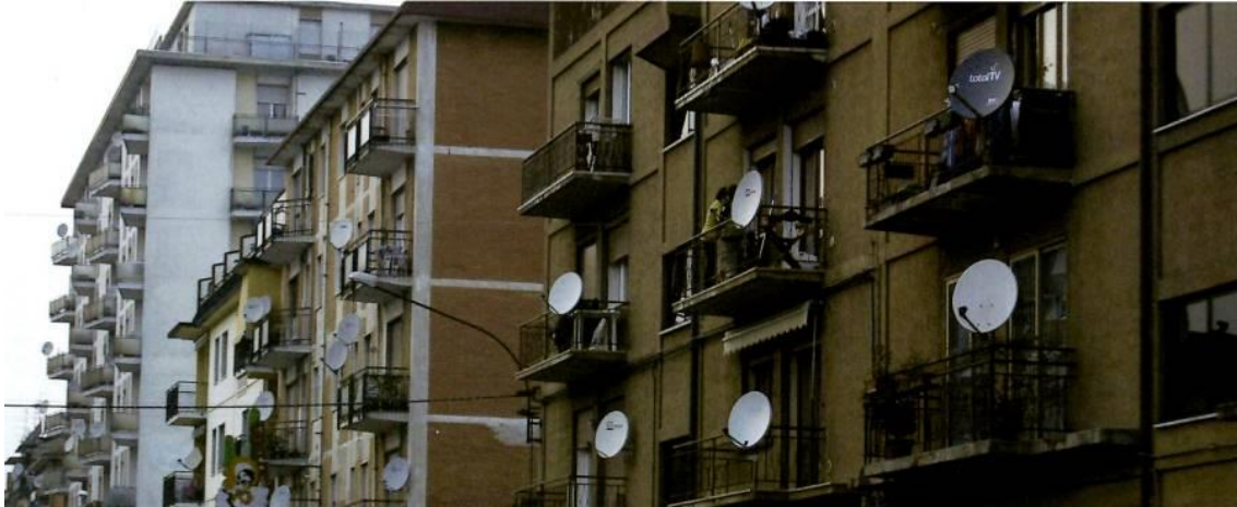
Figura 20. I palazzi di Viale Stazione: un'antenna parabolica per ogni appartamento, per poter seguire i canali TV della madrepatria. In fondo il condominio Monte Berico, o White House 282 .
