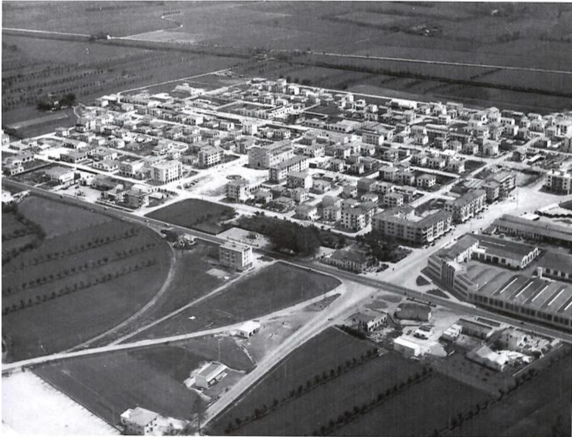
Figura 10. Panoramica di Alte Ceccato nel 1957. Si nota chiaramente l'ortogonalità delle strade e la razionalità e l'ordine alla base del piano regolatore promosso dalla Ceccato 69 .
