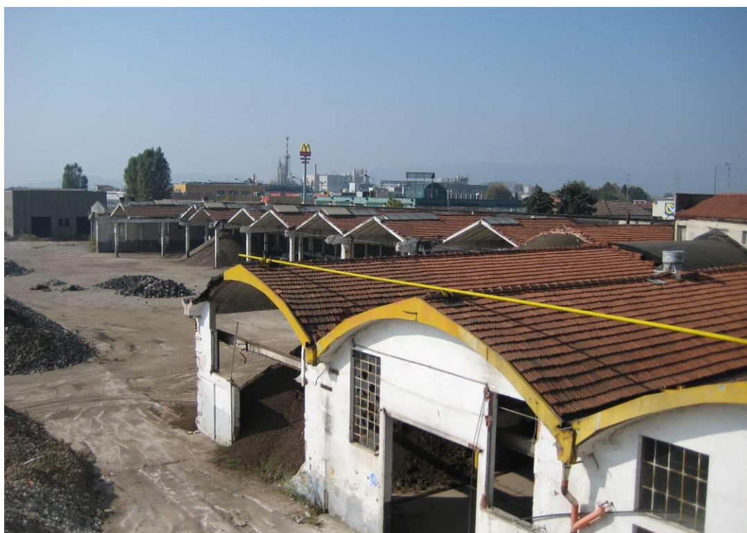
Figura 22 e Figura 23. La vecchia sede della Ceccato poco prima della demolizione (2008) 303 .
