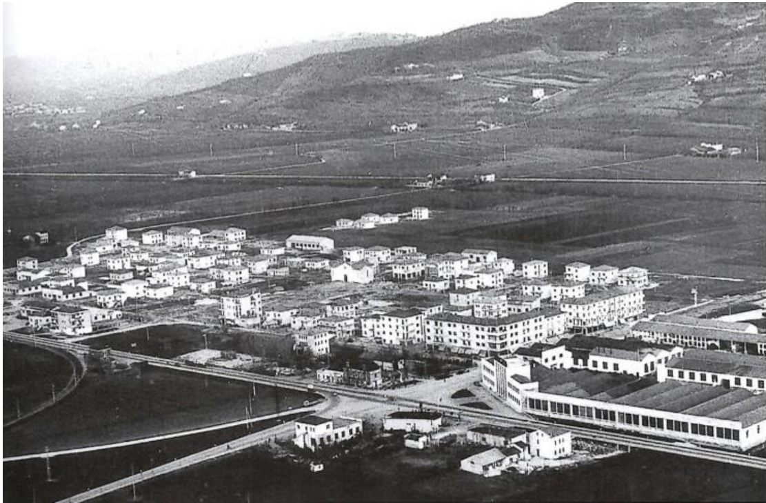
Figura 6. Panoramica di Alte Ceccato nel 1954 40 . In solo un anno gli edifici sono aumentati visibilmente.
