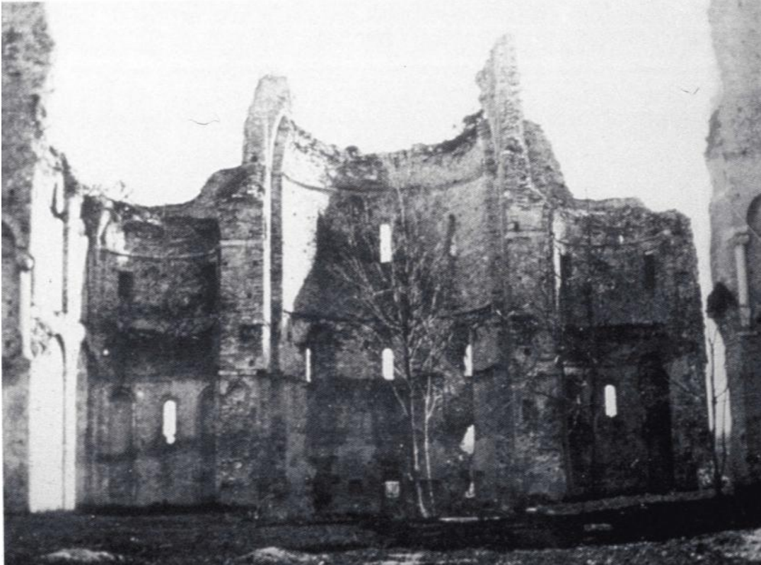
Figura 27 - Fotografia anteriore al 1903: area presbiteriale interna (da DORIGO 1994, p. 276, fig. 262)
