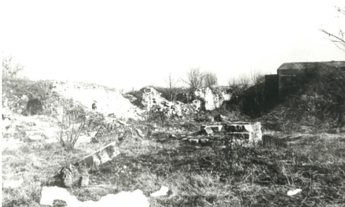
Figura 35 - Dall'archivio Dorigo: "Prima dello scavo"
