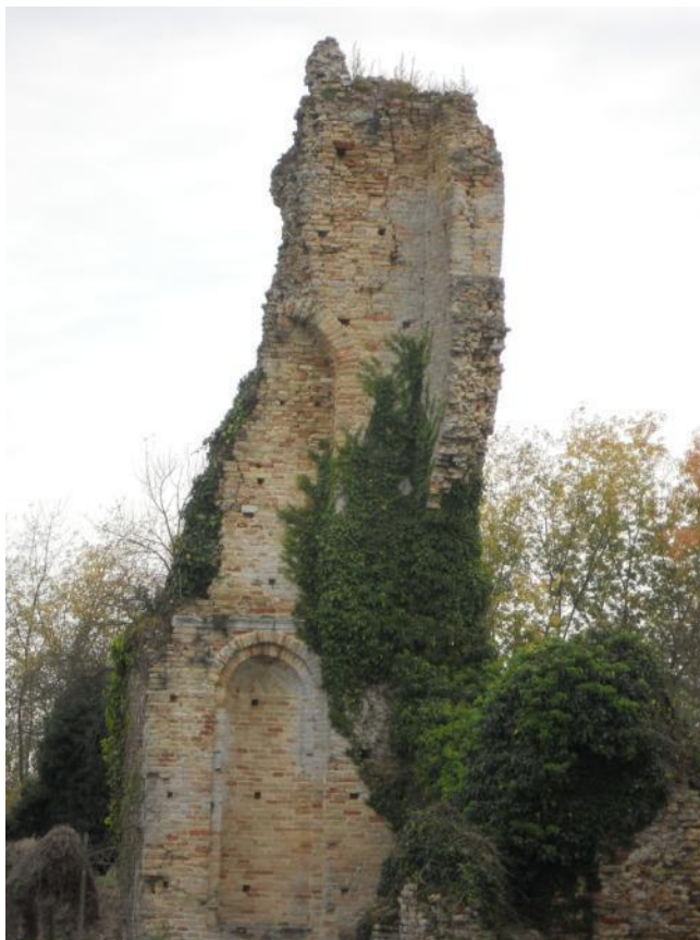
Figura 38 – Tratto ancora in elevato del transetto meridionale (fotografia dell'autrice – ottobre 2015)
