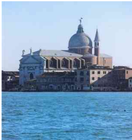
fig. 1 La facciata della chiesa del SS. Redentore dal volume di P. Guidolotti, Andrea Palladio: atlante delle architetture , a cura di G. Beltramini, A. Padoan, Venezia, Marsilio, 2000.
