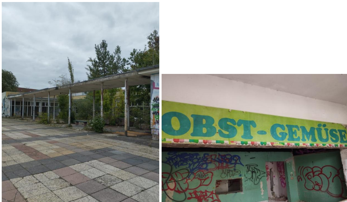
Vecchi negozi in stato di completo abbandono in Platz der Jugend 27
