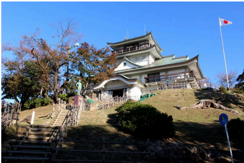
Figura 15: Mastio in cemento armato del castello di Komakiyama
