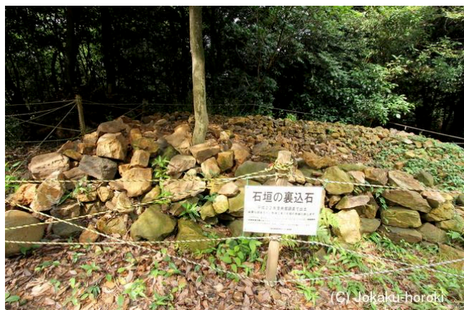
Figura 12: immagine pietre di sostegno 裏込め石
