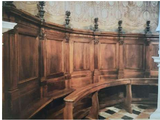
Fig. 81. sopra: (a dx) parete di fondo dell'abside da cui era stato asportato il coro ligneo prima del restauro; (a sx) l'affresco dell'abside durante il restauro; sotto: coro ligneo in noce ricollocato dopo il restauro.
