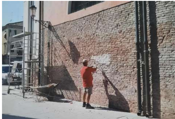
Fig. 79. Intervento di restauro nella parete esterna posta a sud.
