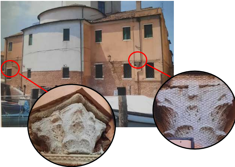
Fig. 10. Veduta del lato meridionale dell'edificio odierno. Nei particolari i due antichi capitelli collocati nell'angolo sud-est e al lato sud-ovest della parete esterna della chiesa.
