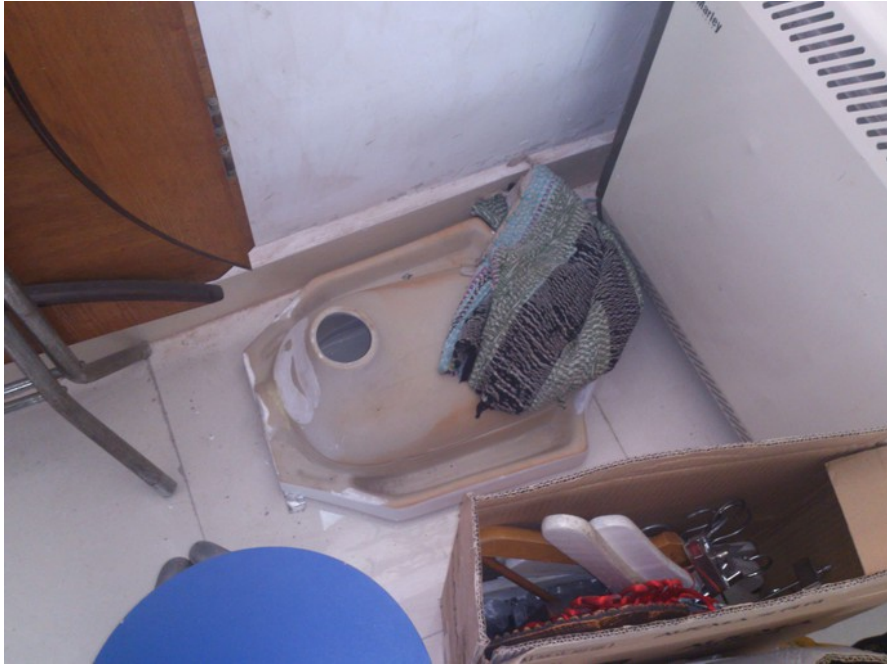
Immagine 16: Water da montare e impianto di riscaldamento.
