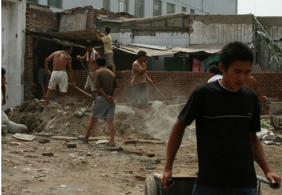
Immagine 5: Demolizione degli hutong vicino Qianmen, nel 2007
