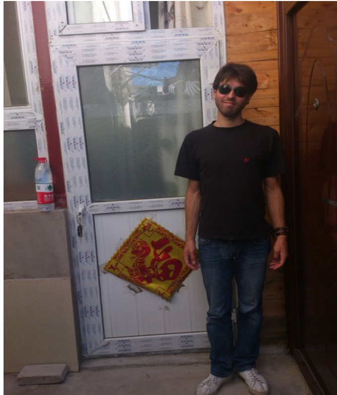
Immagine 12: ingresso di casa, è possibile notare come la parete d'ingresso sia stata realizzata in diversi materiali, compensato nella parte in alto a destra e un piccolo muretto di mattoncini in basso a sinistra, alle mie spalle il carattere fu, 福, fortuna
