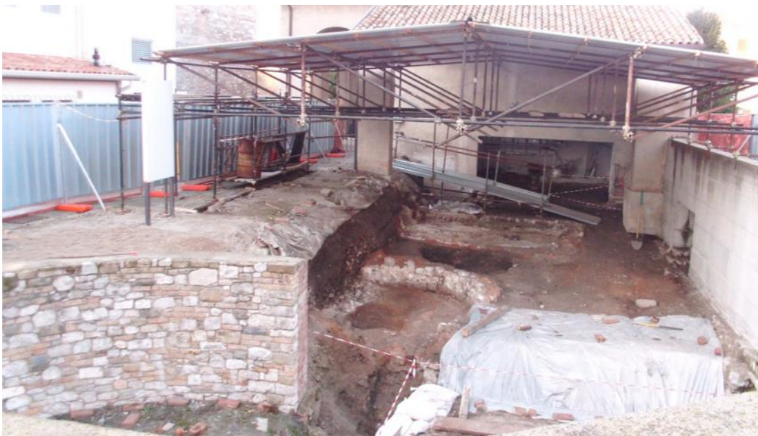
Figura 8 Stalla Violin (lavori in corso)
