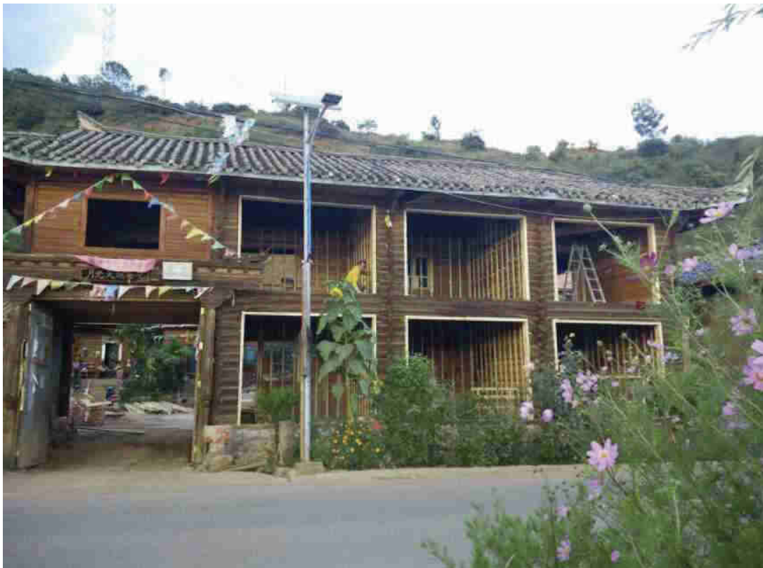
15. Casa di Yang Qing dopo l'inizio dei lavori di ristrutturazione Dazu, 27/10/2014 (foto di Yang Qing)
