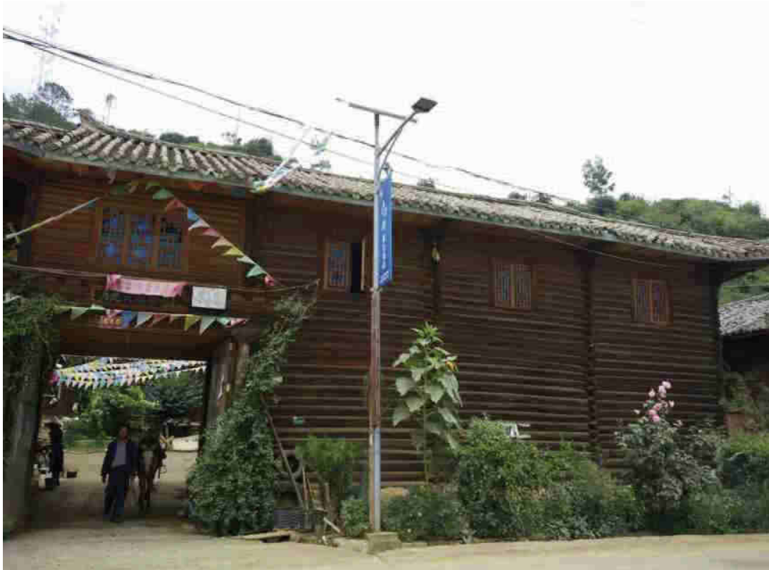
14. Casa di Yang Qing prima della ristrutturazione Dazu, 27/10/2014 (foto di Yang Qing)
