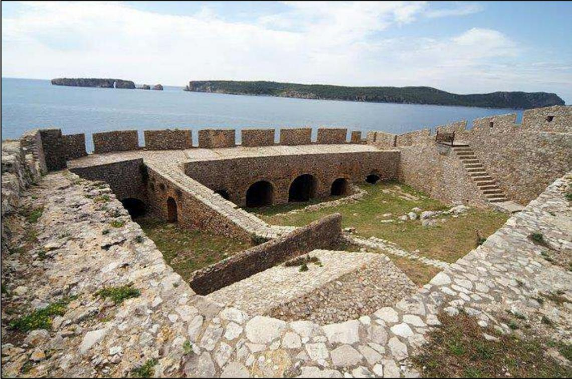
Fig. 98 - Vista del bastione sud-ovest di Nuova Navarino. Si notino le casematte e i merli inspessiti e ingranditi più del dovuto (da <http://pylos.info/en/pylos-sights/niokastro-new-navarino>).
