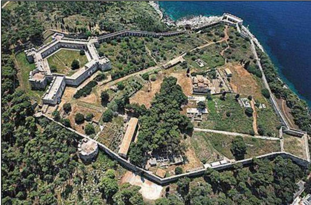
Fig. 96 - Veduta dall'alto della fortificazione di Nuova Navarino. Si possono notare già i due bastioni fronte mare usati per l'artiglieria (da <http://www.kastra.eu/castleen.php?kastro=niokastro>).
