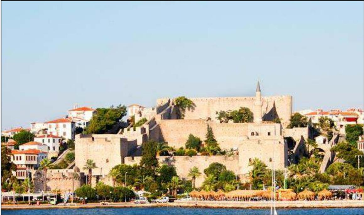
Fig. 61 - Vista d'insieme della fortezza di Çeşme: l'opera ha una forma rettangolare ed ha tre cortine difensive a proteggere l'interno della struttura
