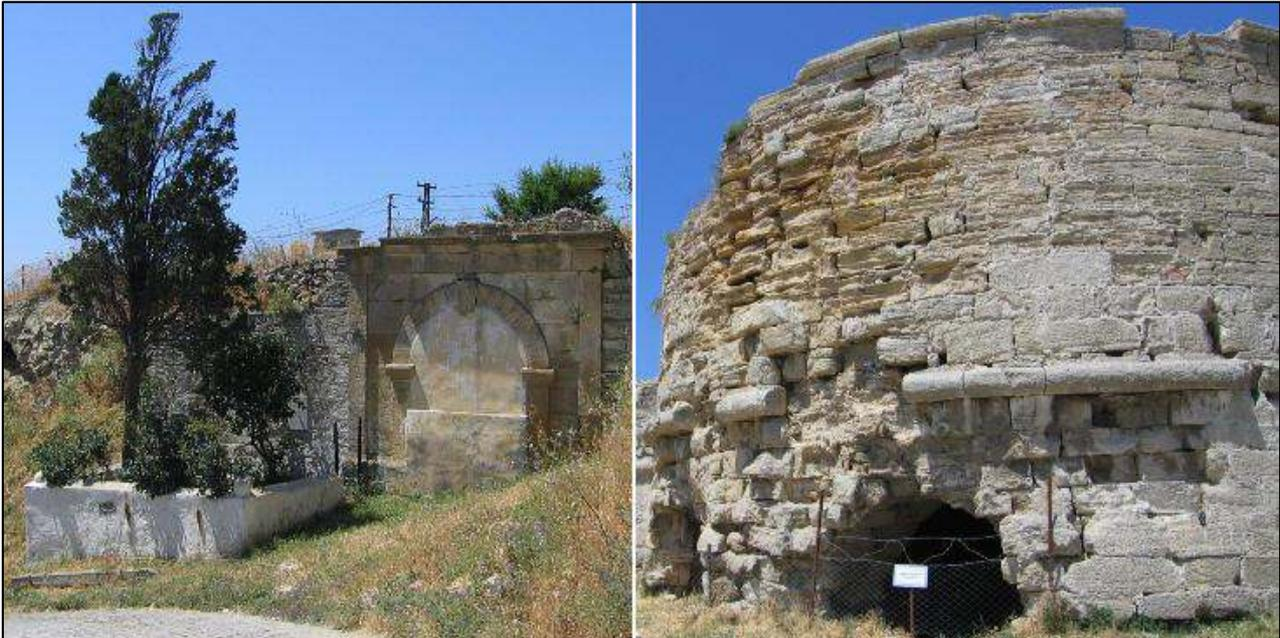
Fig. 54 - Sulla sinistra uno degli ingressi (oggi chiuso) della fortezza di Seddülbahir, a destra una delle due torri circolari con, in basso, i riconoscibili portelli circolari per l'artiglieria (da [romeartlover.tripod.org](http://romeartlover.tripod.org)).
