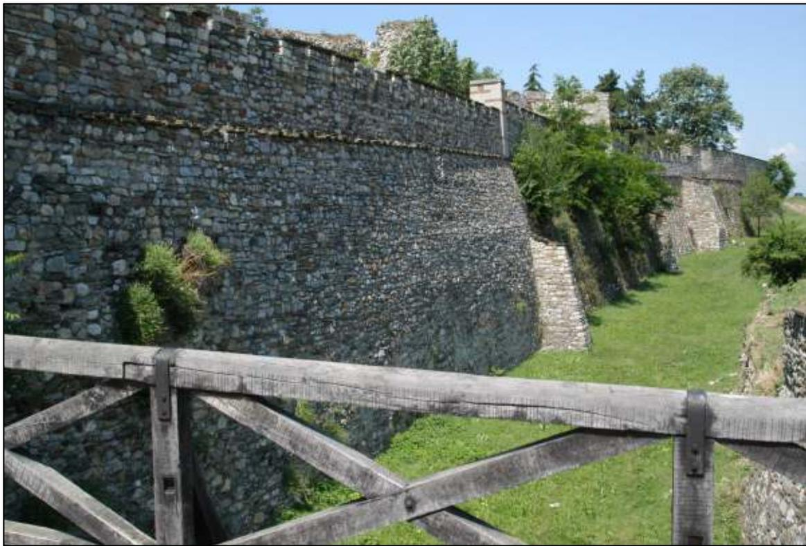
Figg. 108, 109 – In alto (108) linea della cortina sopravvissuta. Si noti la scarpa in aggetto al muro. In basso (109) parte del cammino di ronda della fortezza di Skopije (entrambe da <http://journeymacedonia.com/archaeological/skopje-fortress/>).
