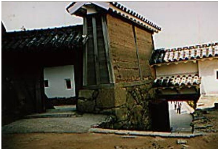
83. Aburakabe. Sezione frontale con a sinistra il mizu no ichi mon ed in basso a destra lo ho no mon 324 .
