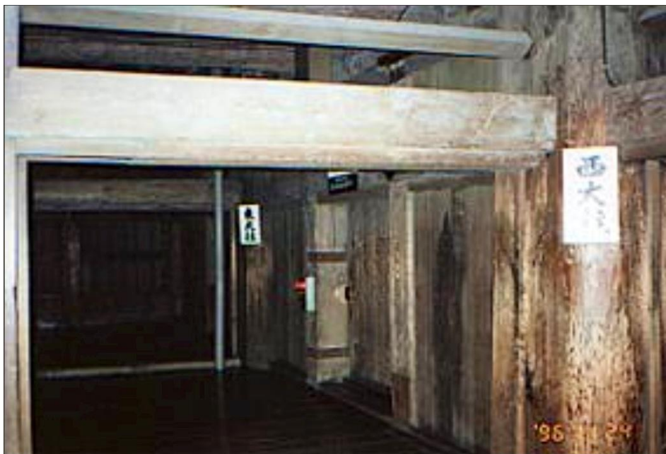
20. Colonna portante che si trova nel basamento del Maschio 155 .
