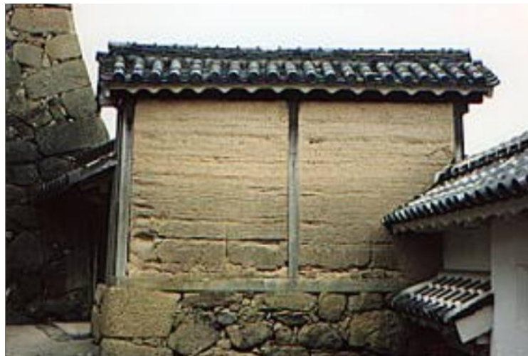
82. Sezione laterale dell'aburakabe 323 .
