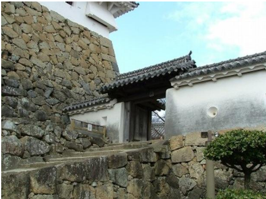
73. He no mon, lato posteriore, a sinistra il muro della parte sud del Dai tenshu kaku 306 .
