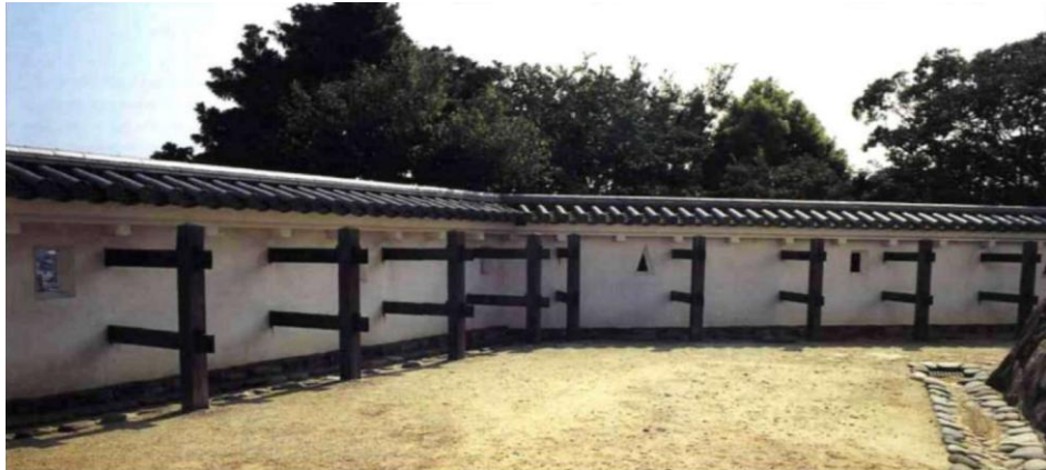
2. Dettaglio: Rinforzi del muro di cinta 45 . (Castello Kakegawa 掛川)
