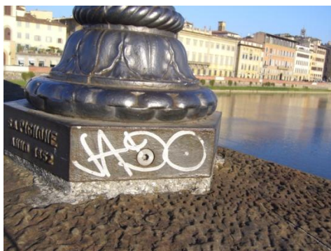
Fig. 3 Ponte alla Carraia, Firenze
