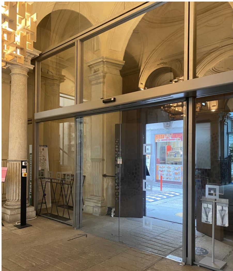
Figura 3.7: Nuova porta d'ingresso automatizzata
