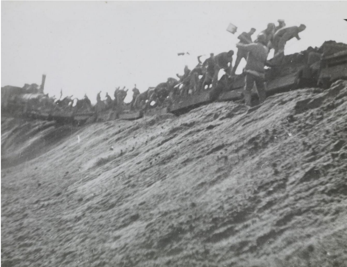
Figura 10. I lavori di scavo del Belomorkanal, 1931-1933. https://gulagmap.ru/ .
