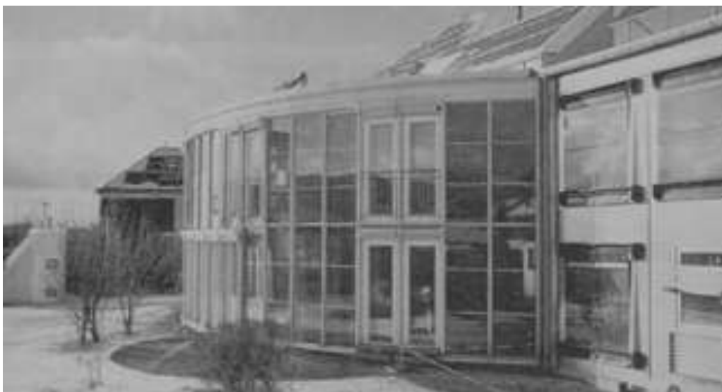
Immagine 1-5 La prima casa solare costruita a Friburgo in Brisgovia (Fonte: Fraunhofer Institute for Solar Energy Research)
