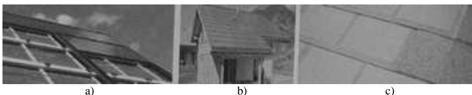
Immagine 1-13 Applicazione integrata nei tetti pavimentati a. Copertura solare fotovoltaica su una struttura in lastre di ardesia b. Copertura solare fotovoltaica su lastre d'ardesia installata sul tetto di un edificio c. Un esempio frequente di copertura con generatori solari (Fonte: Solar Choice)
