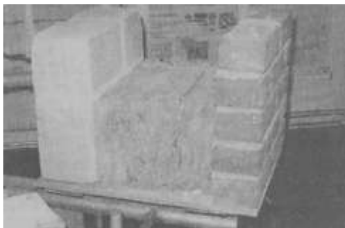
Immagine 2-2 Struttura a blocchi delle mura esterne (Fonte: P.F. Smith)
