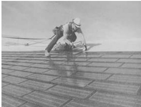
Immagine 1-9 Installazione di impianti fotovoltaici integrati sulle tegole di un tetto (Fonte: Dow Powerhouse)
