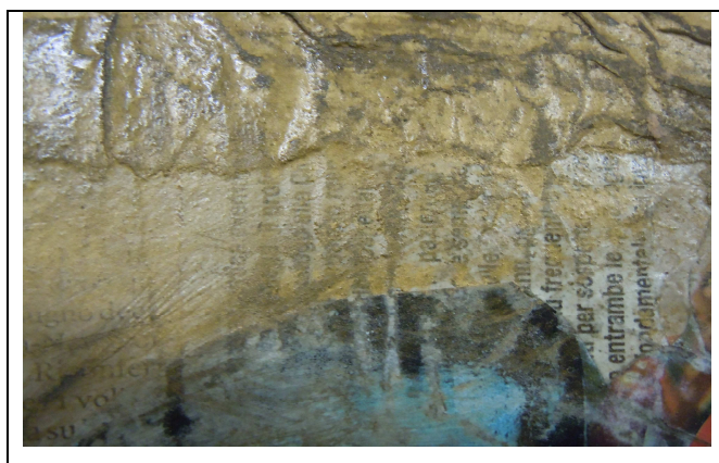
Figura 4: Particolare che mette in evidenza l'incollaggio.
