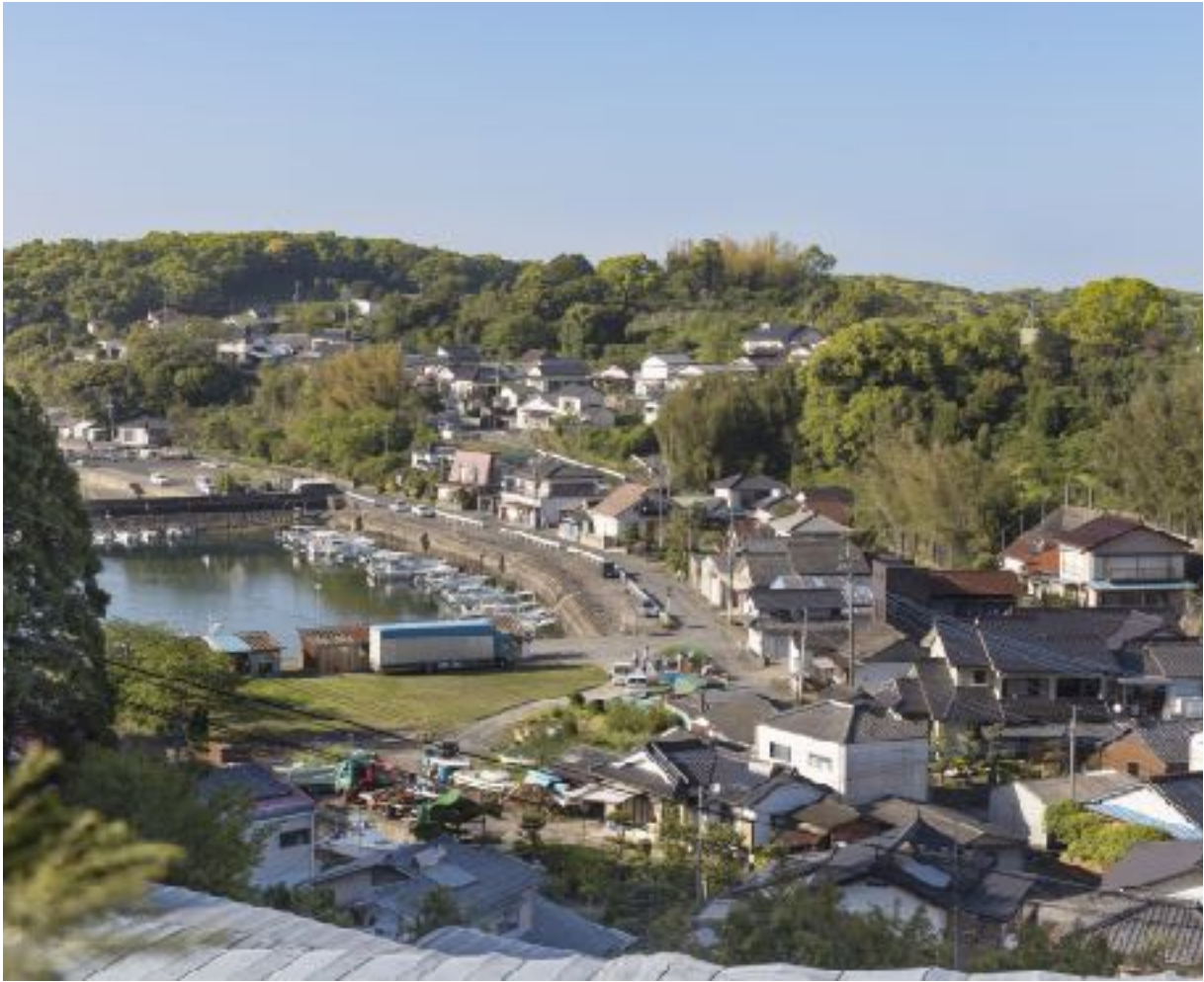
Fig. 6. Il villaggio di Modō fotografato a Maggio 2018. Il bacino portuale è stato dragato di circa due metri per consentire l'accesso al porto e l'uscita anche nelle ore di bassa marea. La battigia è stata sostituita da infrastrutture portuali in cemento armato dalla forma squadrata e un parco, dove è visibile un camion posteggiato. Oltre il primo frangiflutti si nota il nuovo spiazzo interrato dove è stato spostato l'altare di Ebisu. Il paesaggio collinare non mostra più i campi coltivati ma una lussureggiante foresta delimitata da una zona residenziale più densa ed estesa rispetto alla foto precedente. Le macchie di bambù, un materiale oggigiorno non più utilizzato, si slanciano qua e là leggermente ricurve sotto la loro stessa altezza, contenute dagli altri elementi del territorio. I modōmatsu , visibili nella loro forma alta e slanciata sul limite superiore della collina nella foto precedente, sono stati rimpiazzati perlopiù dai tozzi alberi di canfora che in Aprile si tingono di giallo chartreuse. In primissimo piano oltre le serre, si intravede il vero protagonista del territorio, gli alberi di mikan , la cui coltivazione è cominciata nel 1967. Si prega di non riprodurre la foto senza il permesso dell'autore.
