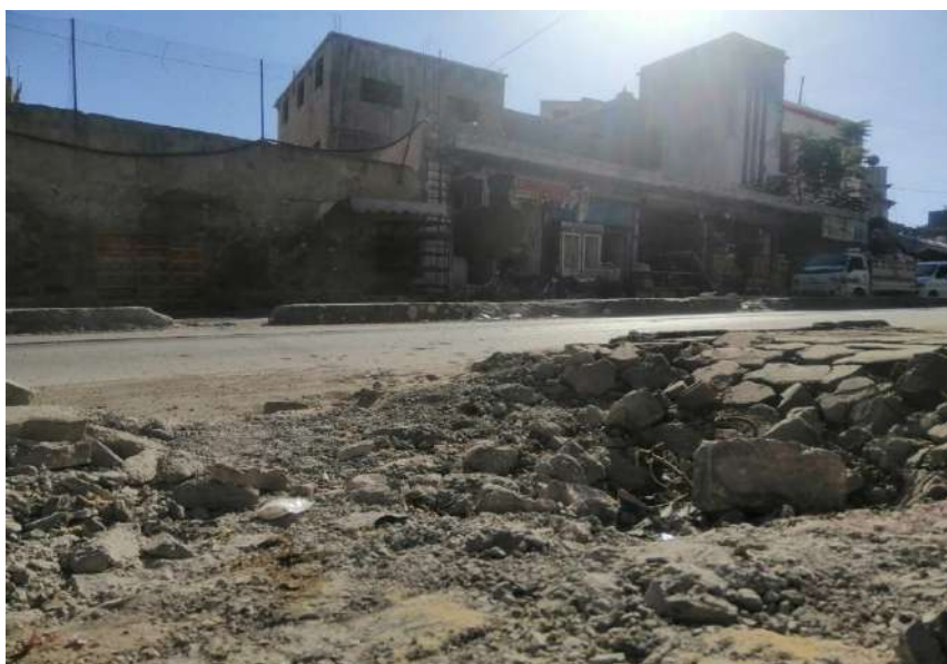
Figura 2 - Condizioni delle strutture scolastiche dopo i bombardamenti dal 2011 ad oggi
