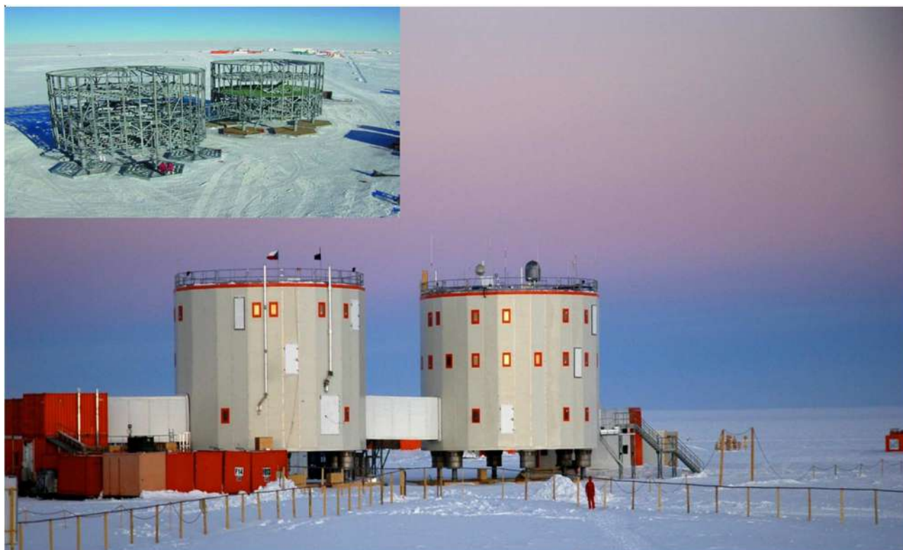
Figura 1.6: Edifici principali della base di ricerca Concordia. In alto a sinistra si può notare lo scheletro metallico di cui è formata la struttura (fonte: ENEA, Ente per le Nuove tecnologie, l'Energia e l'Ambiente, e MNA, Museo Nazionale dell'Antartide).
