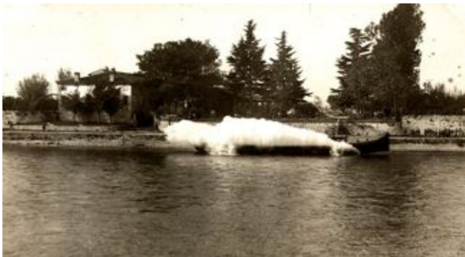
Esempio di varo di traverso
