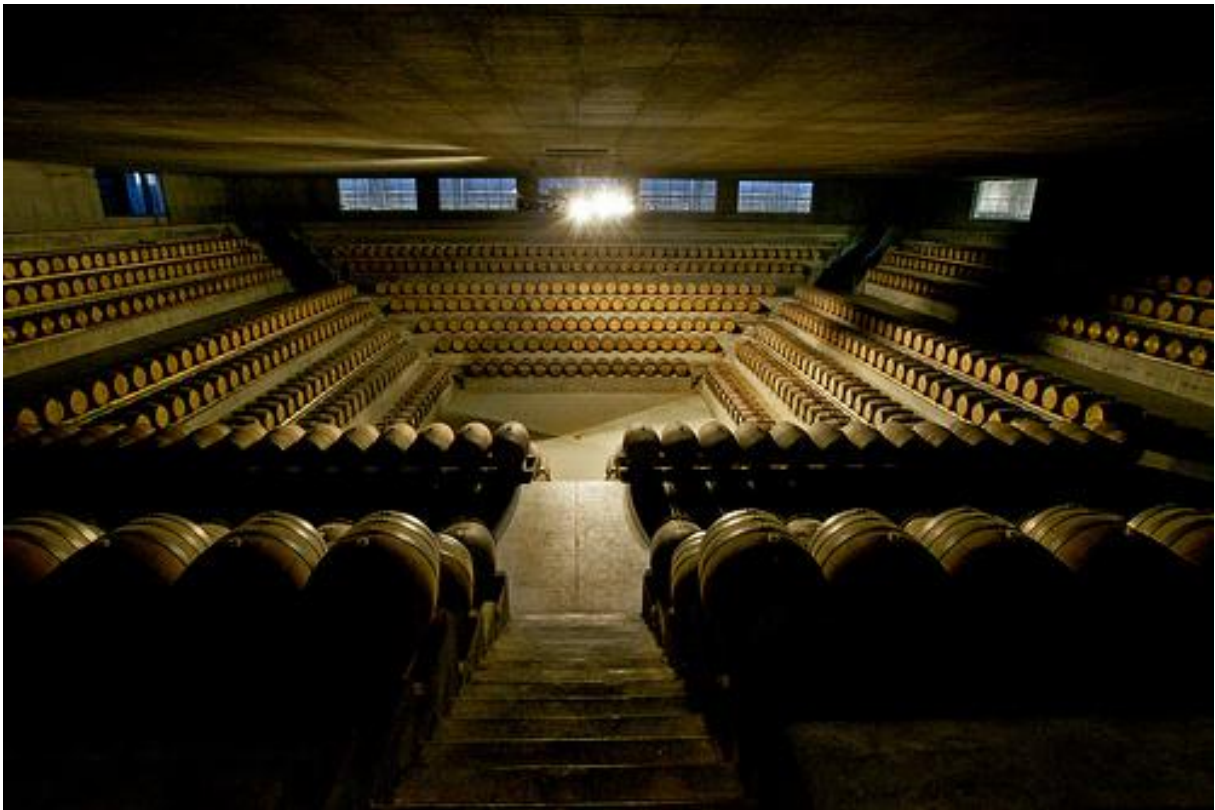
Figura 3-13. Barriccaia sotterranea a gradoni, in cemento armato, Renzo Piano per la cantina Rocca di Frassinello
