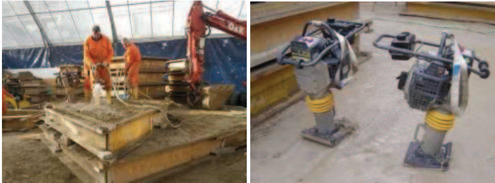
Figura 35 Compattazione dei blocchi di sabbia e macchine compattatrici, archivio Sultans of Sand.
