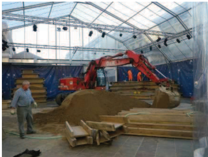
Figura 34 Fase preparatoria di compattazione meccanica dei blocchi di sabbia, archivio Sultans of Sand.
