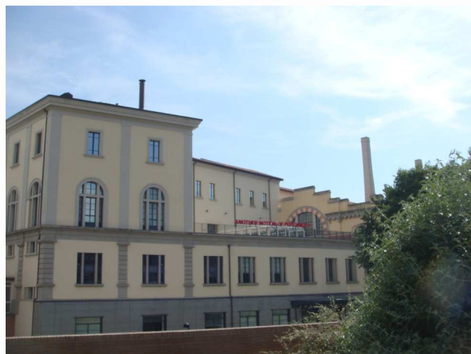
Fig.4 Particolare dei camini originari
