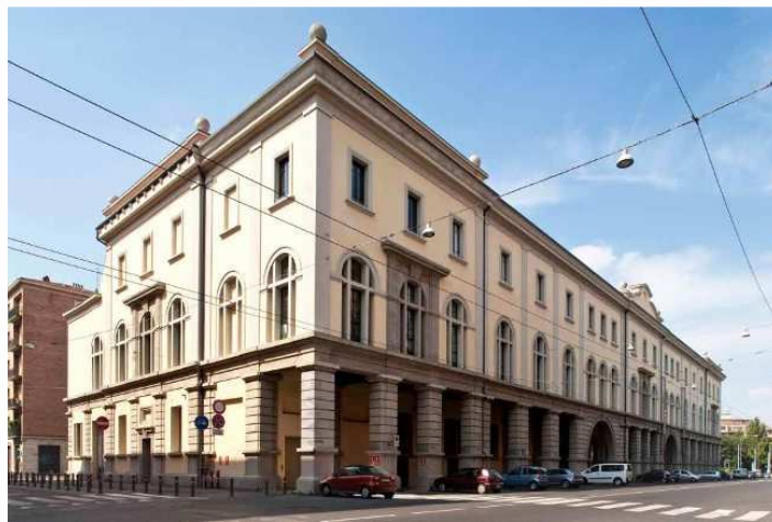
Fig.1 Facciata esterna del museo
