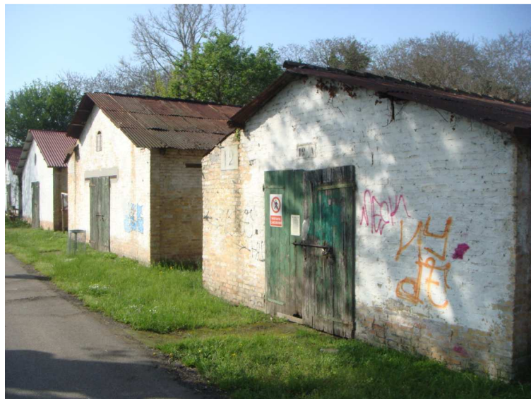
Fig.8 Particolare dei magazzini
