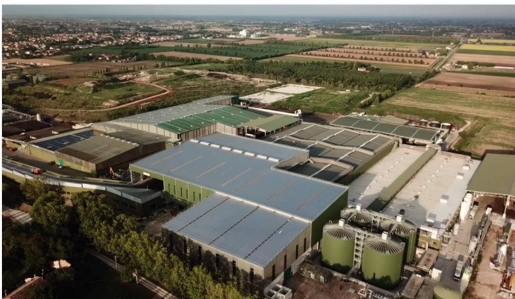
Figura 1 - Impianto di S.E.S.A., Este (PD)
