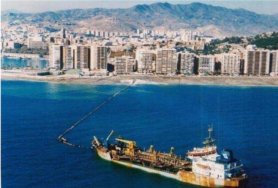
Figura 2.11 - Esempificazione di un trasferimento di sabbia dalla cava marina alla spiaggia
