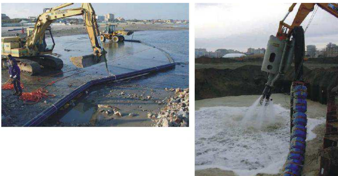
Figura 2.13 - Attuazione della tubatura by-pass al Porto di Garibaldi
