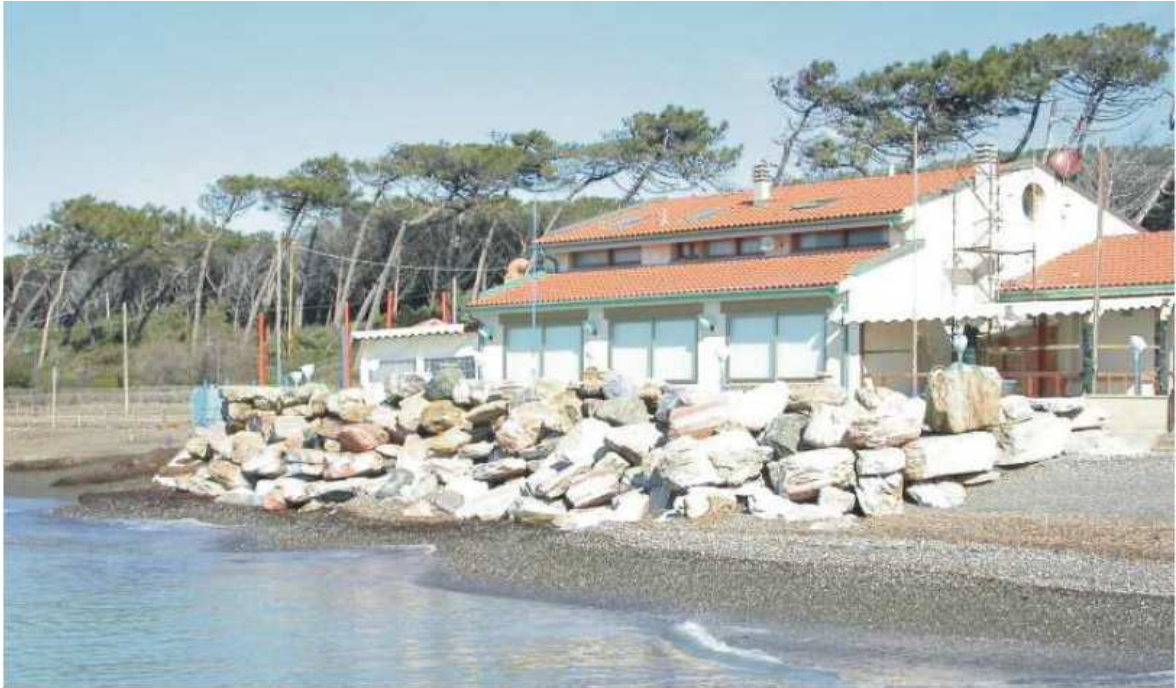
Figura 2.5 - Esempio di scogliera radente
