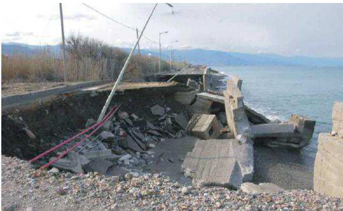
Figura 2.3 - Conseguenze dell'attacco ondoso su una strada litoranea
