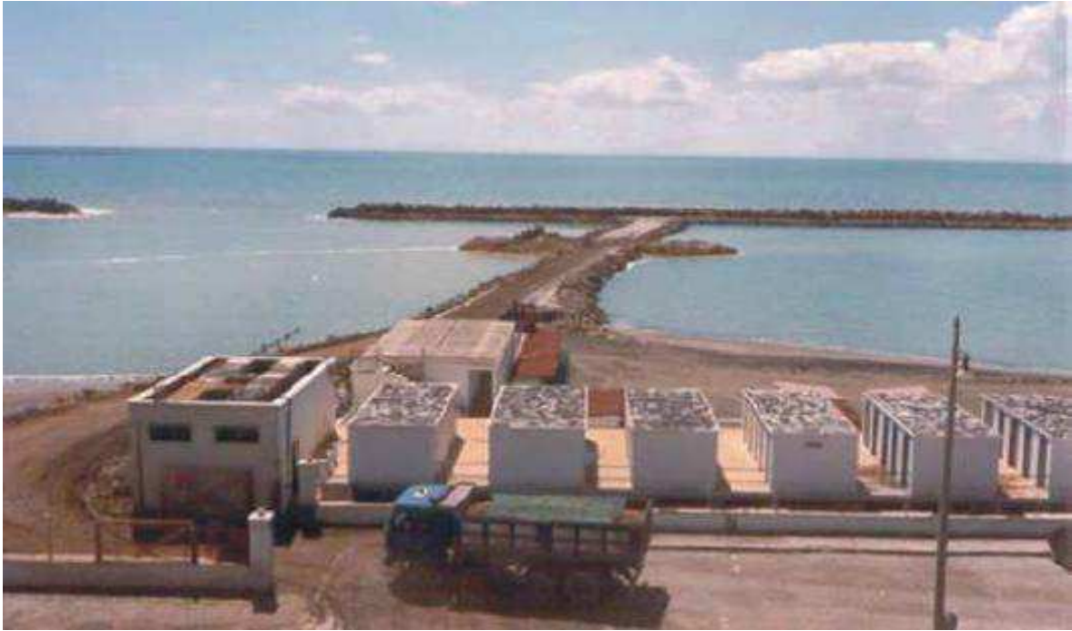
Figura 2.14 - Immagine di repertorio scattata a Ostia durante i lavori di ripascimento con l'utilizzo di materiale da cava
