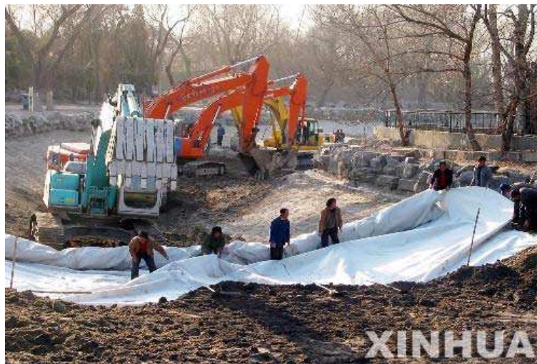
Foto 7: Questa scena è probabilmente ciò che si è trovato davanti Zhang Zhengchun durante la sua visita al parco Yuanmingyuan . Infatti la foto, scattata qualche giorno dopo (il 24 marzo 2004), mostra alcuni operai porre la membrana impermeabile sui fondali dei laghi del Parco.
