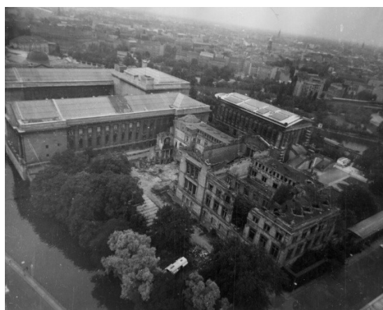
Figura 22. Visione aerea dell'isola dei musei di Berlino: al centro il Neues Museum gravemente danneggiato dai bombardamenti della Seconda guerra Mondiale. Fonte: https://davidchipperfield.com/projects/neues-museum
