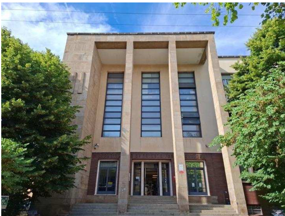
Fig.25 – Dipartimento di Scienze del Farmaco . Fonte: fotografia dell'autore, 2026
