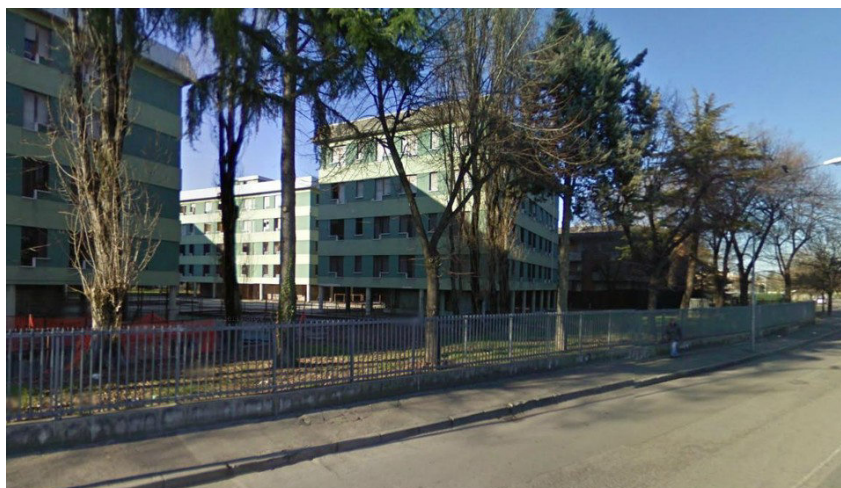
Figura 9: il residence "La Serenissima" a Padova 71 .
