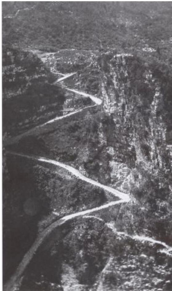
Figura 1: La "Calà del Sasso" in Valstagna. Risina costruita da Gian Galeazzo Visconti alla fine del Trecento, è caratterizzata da 4444 gradini e da una canaletta concava selciata di pietra per agevolare e controllare la discesa dei tronchi a valle.
