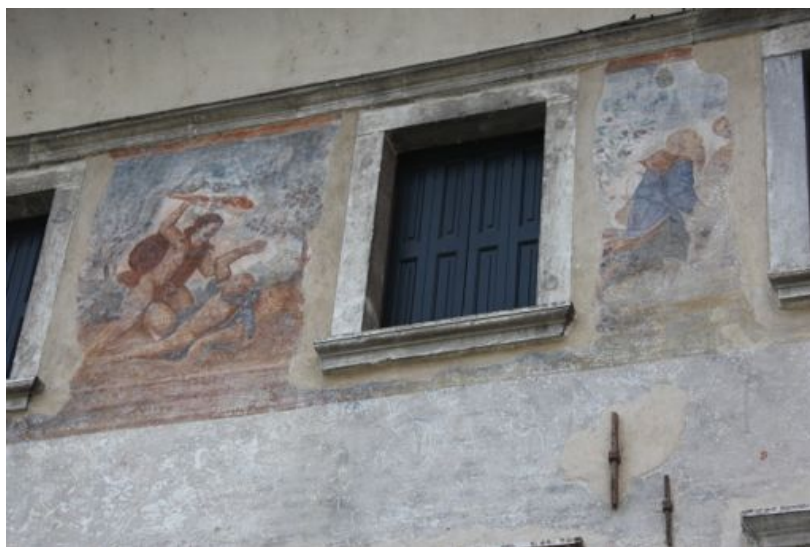
Figura 61: Casa Someda, Caino e Abele, particolare.
