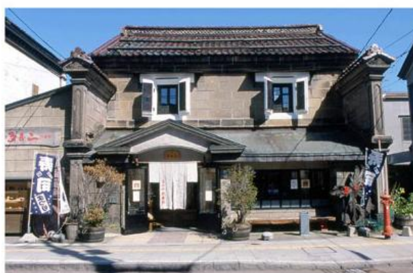
Figura 6: Prima e dopo il processo di ristrutturazione di una vecchia pescheria. Otaru shi shitei rekishiteki kenzō butsu dai 34 go “Kaneko Motosabuto ten” 小樽市指定歴史の建造物第34号「旧金子元三郎商店」(Edificio storico n.8 della città di Otaru “ex-negozio di orologi Iwanaga”), in “Otaru-shi 小樽市”, 2020, https://www.city.otaru.lg.jp/docs/2020101500627/ , ultimo accesso 20-09-2026.
