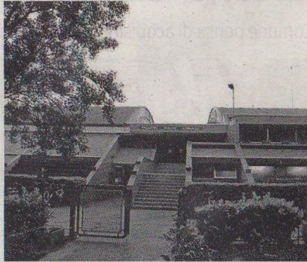
L'ingresso alla piscina, domani riservata alle donne (foto Candussi)
