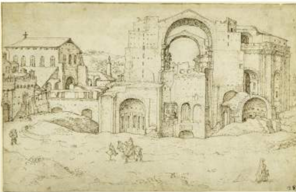
9. M. van Heemskerck, Veduta del cantiere di San Pietro , 1536 ca., Berlino, Kupferstichkabinett der Staatlichen Museen
