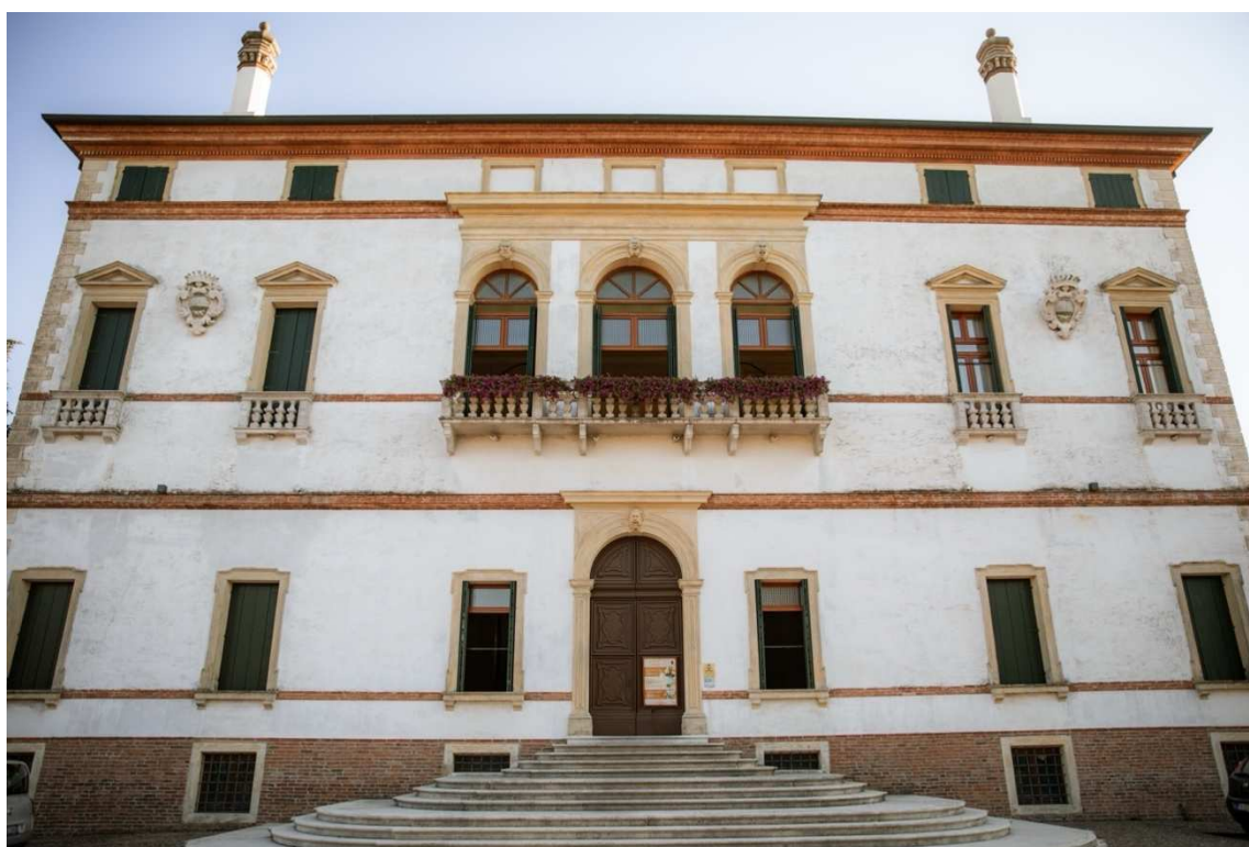
Figura 11: realizzazione facciata sopra il fiume Adigeto, verso Tramontana.
