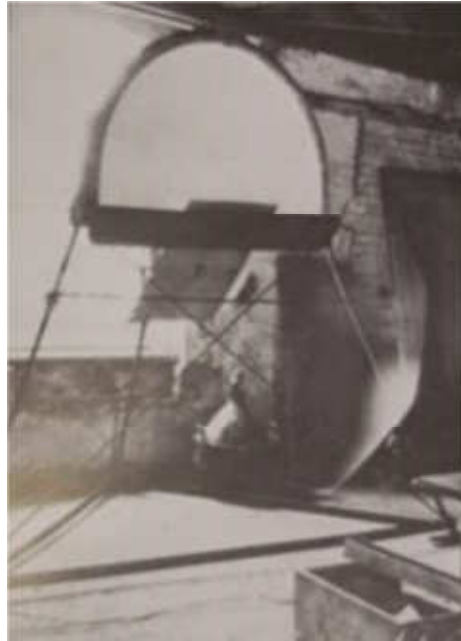
Figura 23 - M. Fortuny y Madrazo, modello sperimentale in gesso per la cupola, Parigi, 1902
