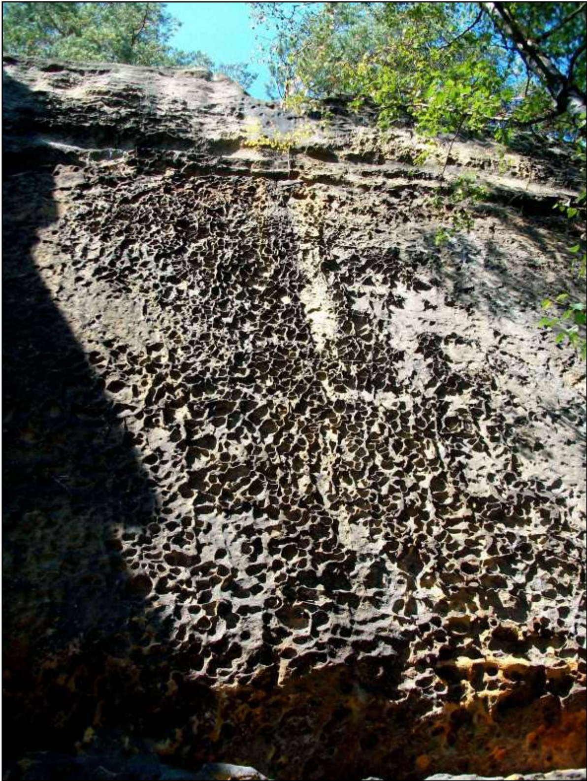
Figura 37 - Conformazione ad alveare nell'arenaria della Svizzera Sassone, (Foto dell'autrice).
