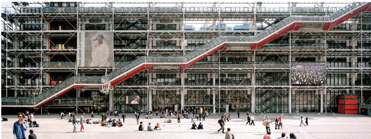
1. Foto della facciata del Beaubourg presa dal sito www.artwave.it
