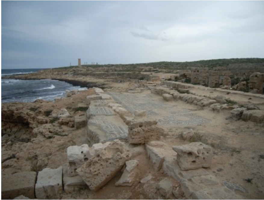
Fig. 46 – Le Terme a mare di Sabratha; si notano crolli e danneggiamenti delle strutture e dei mosaici pavimentali geometrici a causa dell’erosione marina (foto gentilmente concessa dal prof. Beltrame).
