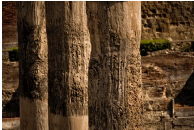
Fig. 30 – Colonne del mercato romano di Pozzuoli con perforazioni causate da molluschi marini (da http://www.natgeocreative.com/photography/2281851 ; ultima consultazione 16/02/2017).
